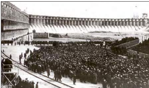
Будівництво Дніпрогес у Запоріжжі. 1930-ті рр.
