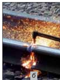
Мал. 30. Зварювання (а) і різання (б) металу
