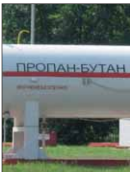
Мал. 37. Ємність із пропан-бутановою сумішшю на автозаправній станції
