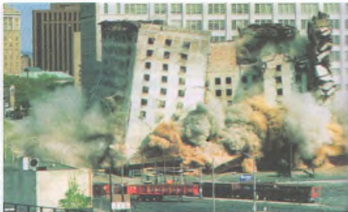
Мал. 94. Динаміт використовують для демонтажу будівель
