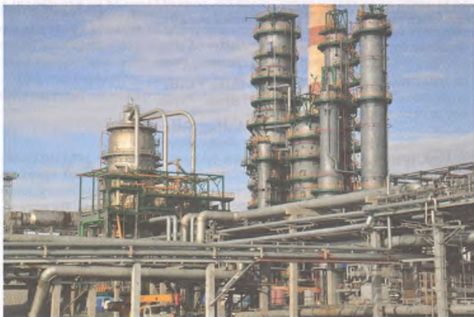
Мал. 76. Загальний вигляд сучасного нафтопереробного заводу
