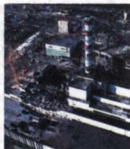
Рис. 73. Зруйнований енергоблок Чорнобильської АЕС відразу після аварії
