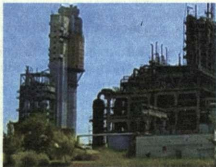
Рис. 17. Завод з виробництва амоніаку (зліва — колона синтезу)
