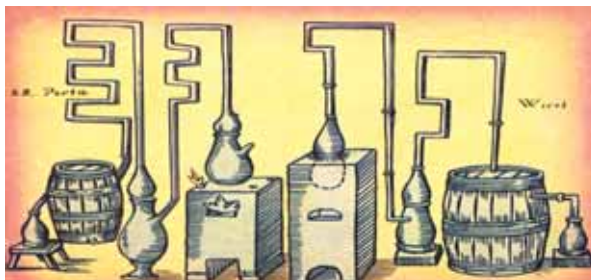
Мал. 90. Апарати для перегонки спирту (XVI ст.)
