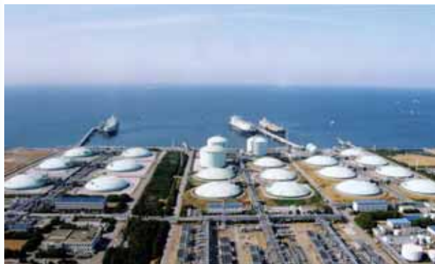
Мал. 20. Резервуари для зберігання скрапленого природного газу
