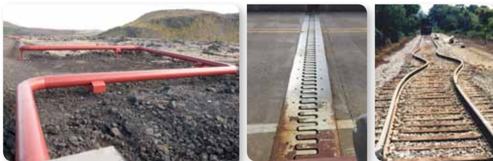
Мал. 140. Теплове розширення конструкцій
