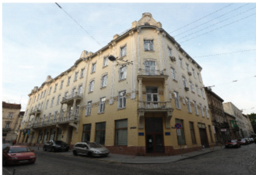
Адміністративна будівля Львівської митниці
