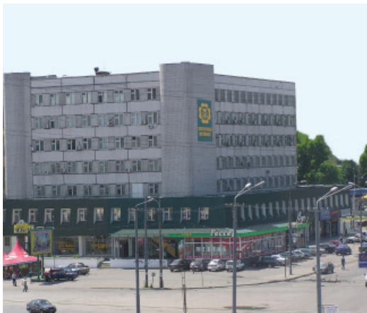
Адміністративна будівля Дніпропетровської митниці
