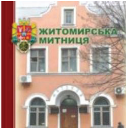
Адміністративна будівля Житомирської митниці
