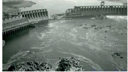
Іл. 32.7. Зруйнована вибухом гребля Дніпрогесу в 1941 р.
