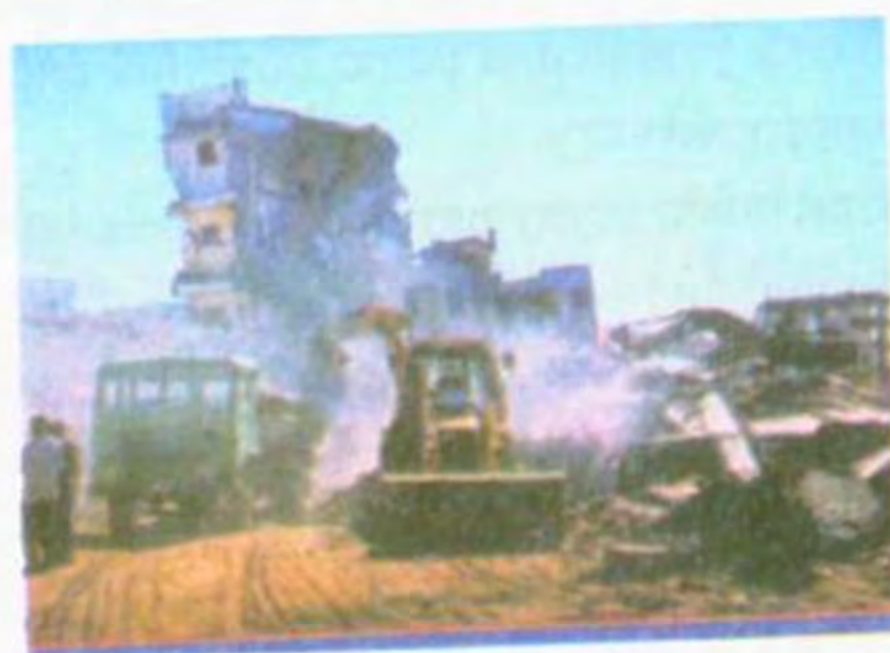
Іл. 38.6. Аварійно-відновлювальні роботи після землетрусу
