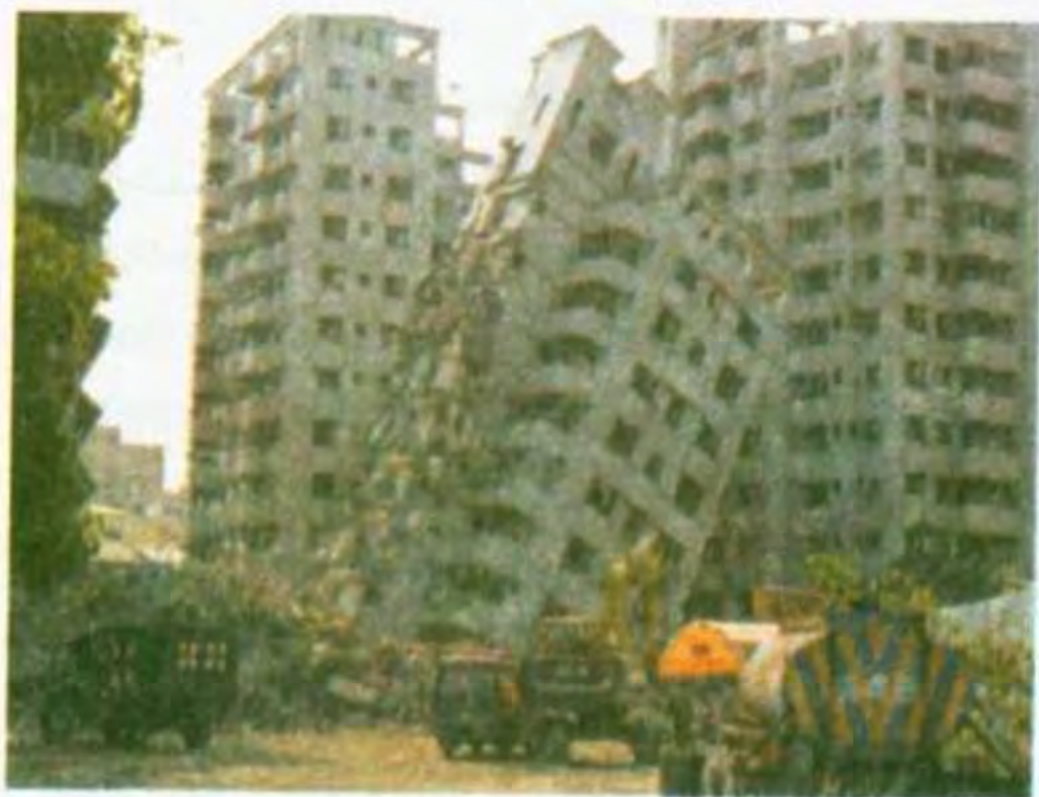
Іл. 30.1. Наслідки землетрусу
