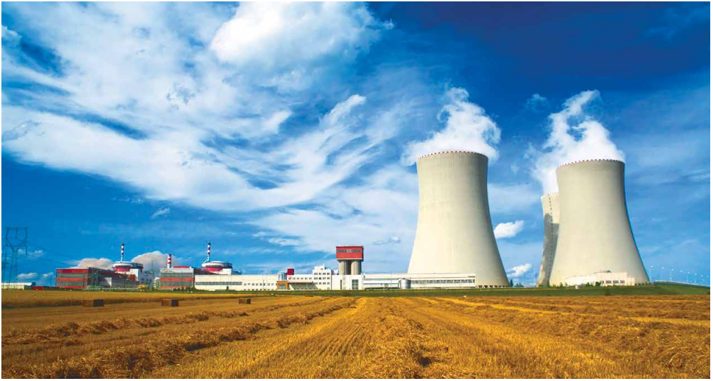
Мал. 31.3. Атомна електростанція на модульних реакторах
