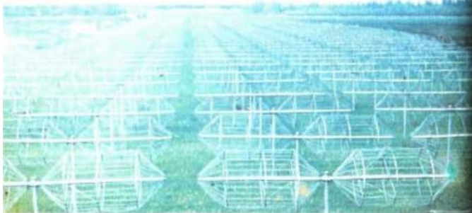
Рис. 6.9. Тисячі антен найбільшого у світі радіотелескопа УТР-2 (Український Т-подібний радіотелескоп) зверху мають вигляд велетенської літери "Т" з розмірами 1800 × 900 м
